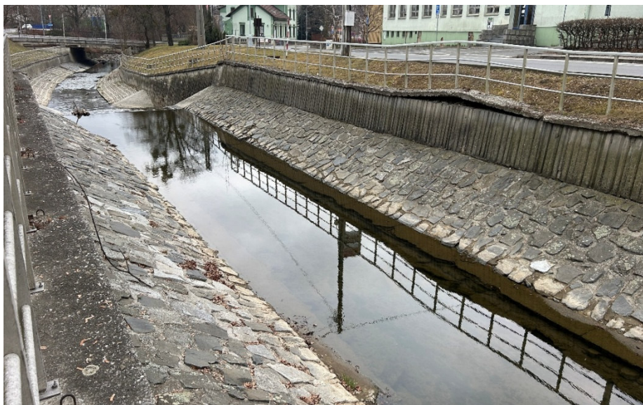
Obrázek: Oprava parapetní desky na opěrné zdi v km 10,154 – 10,161 (pohled z levého břehu po proudu). Dočasně odstranění zábradlí.
